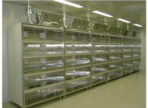
(施工例) 東京大学医学部
