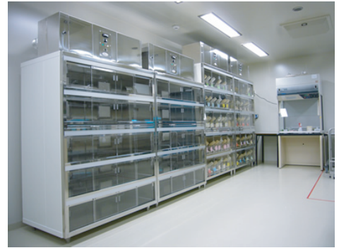
(施工例) 東京大学医学部
